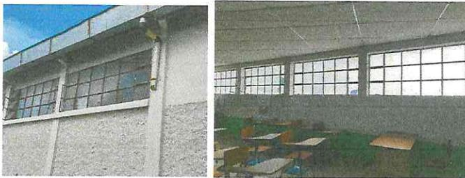
Foto 5: Sustitución de ventanas de metal por ventanas de PVC.
